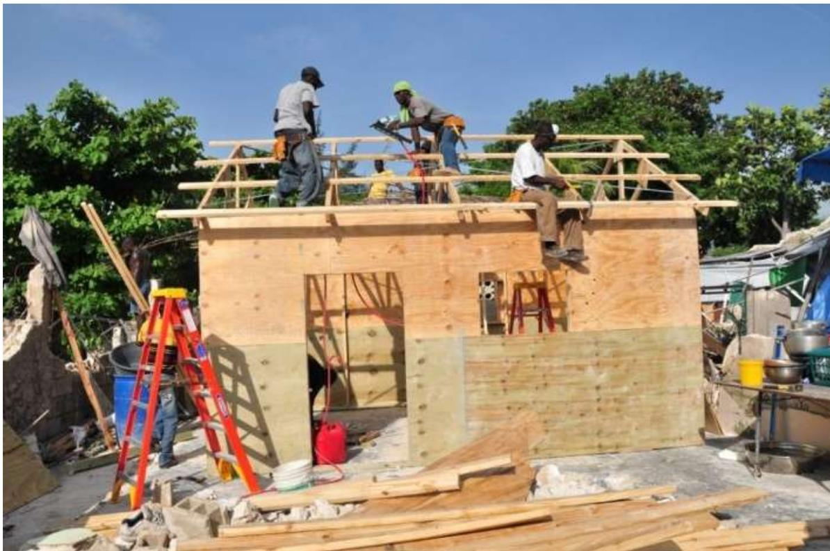
UNOPS construirá 5000 viviendas en los próximos seis meses y ha diseñado una estructura de madera cuya vida útil se estima en 3 años
